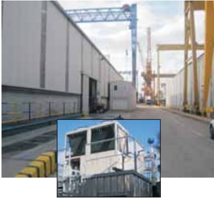
Tuzla gemi tersanesi 130kW-Isıtma-Soğutma
