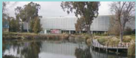
Wagga Wagga Civic Center, Ofis ve Residence, Avustralya 10.000 m 2 , 1630 kW, soğutma, 1330 kW ısıtma ve sıcak su Su kaynaklı ısı pompası, Sudan suya yöntemi
